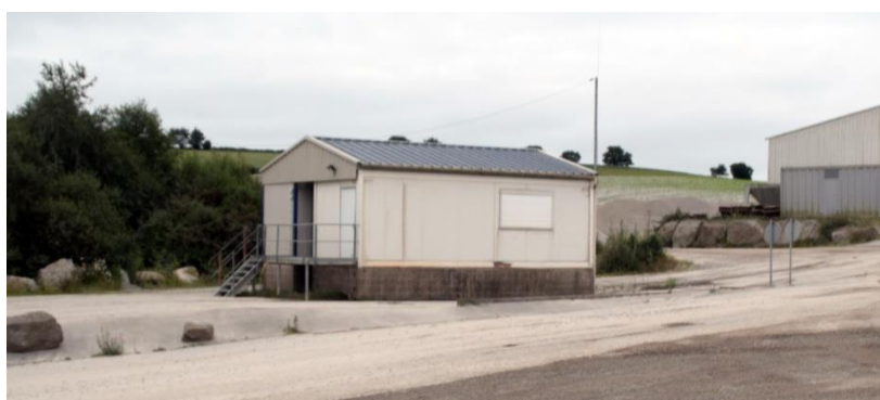
Accueil et pont-bascule du site
